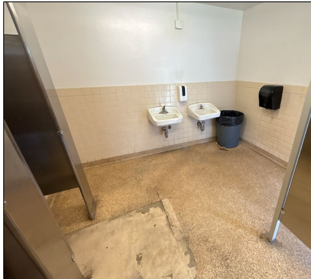
Del Paso ES Restroom (Existing)
